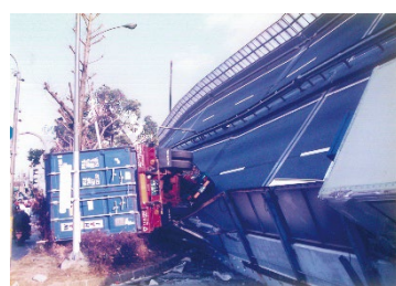
（高速道路の倒壊により横転したトラック）
